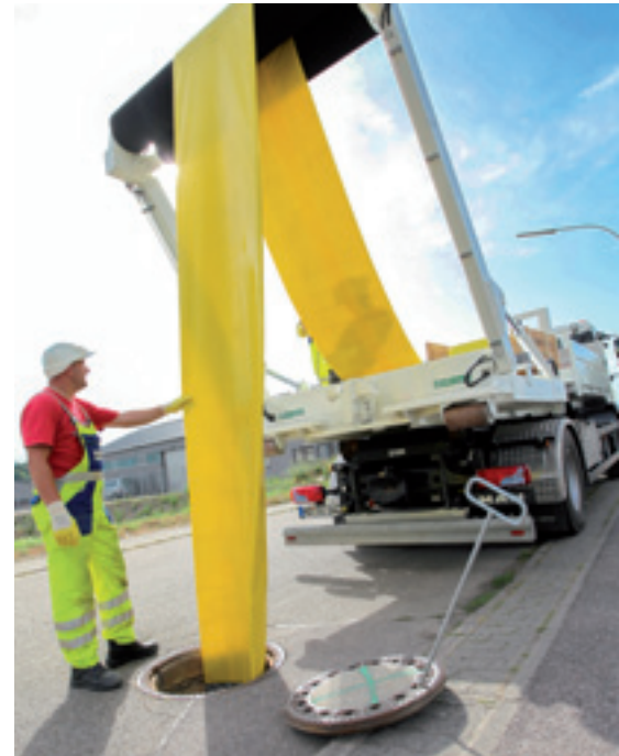
Sanierung einer Abwasserleitung im Schlauchlining-Verfahren
